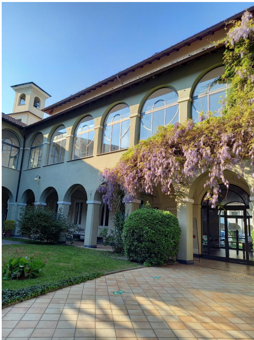
Ingresso Sala Conferenze - Biblioteca Civica di Novi Ligure
